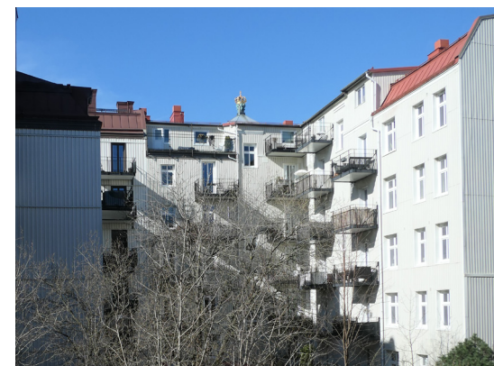
Gårdsfasader som genomgått taklyft. I gatuhuset har det även tillkommit en takterrass.
