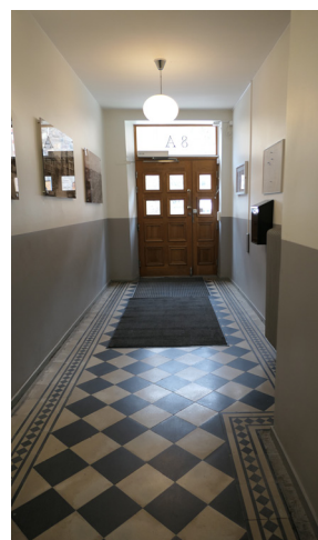
Huvudtrapphusen mot gatan är välbevarade med äldre cementplattor lagt i schackrutsmönster med fris, ursprungliga räcken av gjutjärn och stuckfriser på lägenhetsplan.
