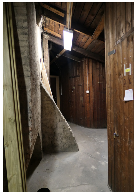
Vinden har en välbevarad karaktär med ursprungliga murstockar, äldre vindsförråd och i stora delar en ursprunglig takkonstruktion.
