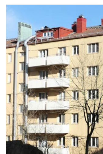
Övre Husargatan 5, uppförd 1936, med ursprunglig takkupa mot tvättstuga.
