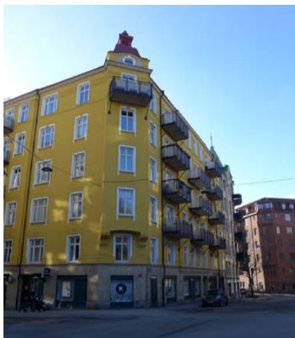
Gatufasad Risåsgatan 8 i intilliggande kvarter.
