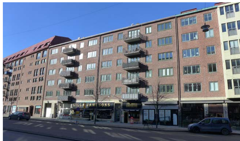
Gatufasad Övre Husargatan 5-7, uppförda 1936. Till vänster syns även 1980-talsbyggnaden på Övre Husargatan 9-11 med sitt högresta tak.
