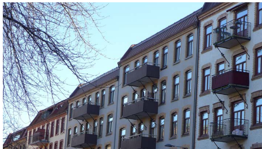
Taklandskapet mot Kastellgatan med sina branta nedre takfall.
