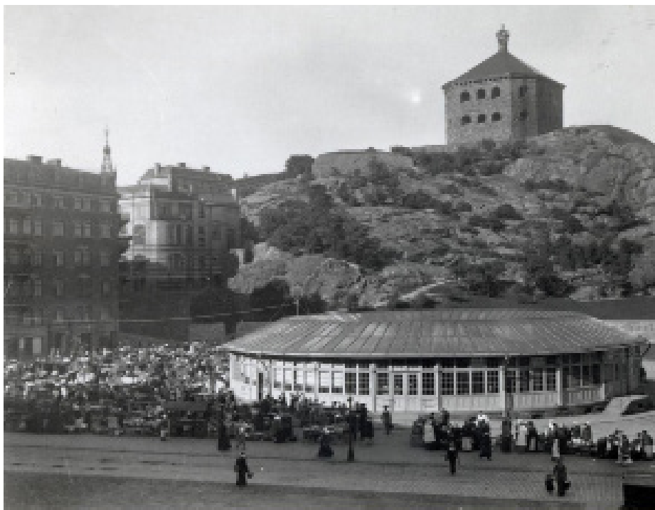
Fotografi över Skanstorget år 1915 med den runda saluhallen i förgrunden. Ovan saluhallen syns Skansen Kronan. Till vänster i bild anas kvarteret Batteriet och byggnaden på Skanstorget 10. Källa: Göteborgs Stadsmuseum.
