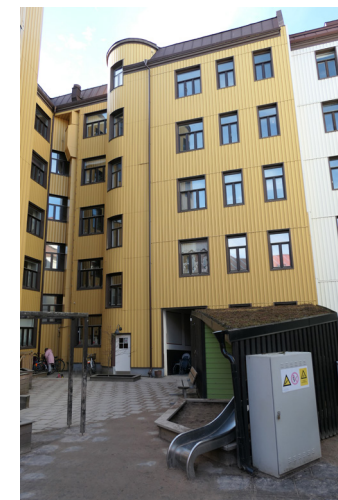
Tilläggsisolerade gårdsfasad Kastellgatan 12, uppförd 1900.
