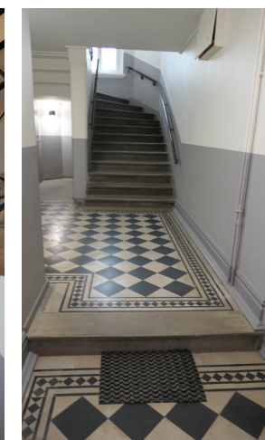
Huvudtrapphusen mot gatan är välbevarade med äldre cementplattor lagt i schackrutsmönster med fris, ursprungliga räcken av gjutjärn och stuckfriser på lägenhetsplan.
