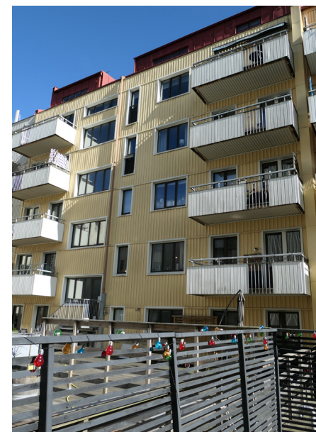
Tilläggsisolerad och plåtklädd gårdsfasad.
