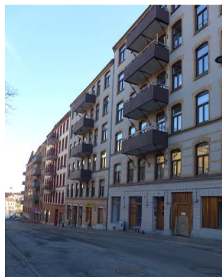
Från gatunivå är takfallen mot gatan inte synliga.
