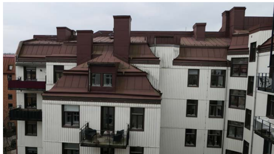
Gårdshus på Kastellgatan 8. Takkupan är i ursprungligt läge, men har byggts om under senare tid. Här syns även hur fönster mot gårdstrapphuset har satts igen i samband med att hiss installerades i trapphuset.
