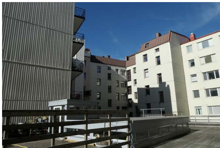
Gårdsfasad Skanstorget 10, uppförd 1898. Fasaden är tilläggsisolerad och klädd med plåt. I takfallet har det tillkommit inverterade takkupor.
