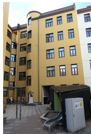
Tilläggsisolerad gårdsfasad.
