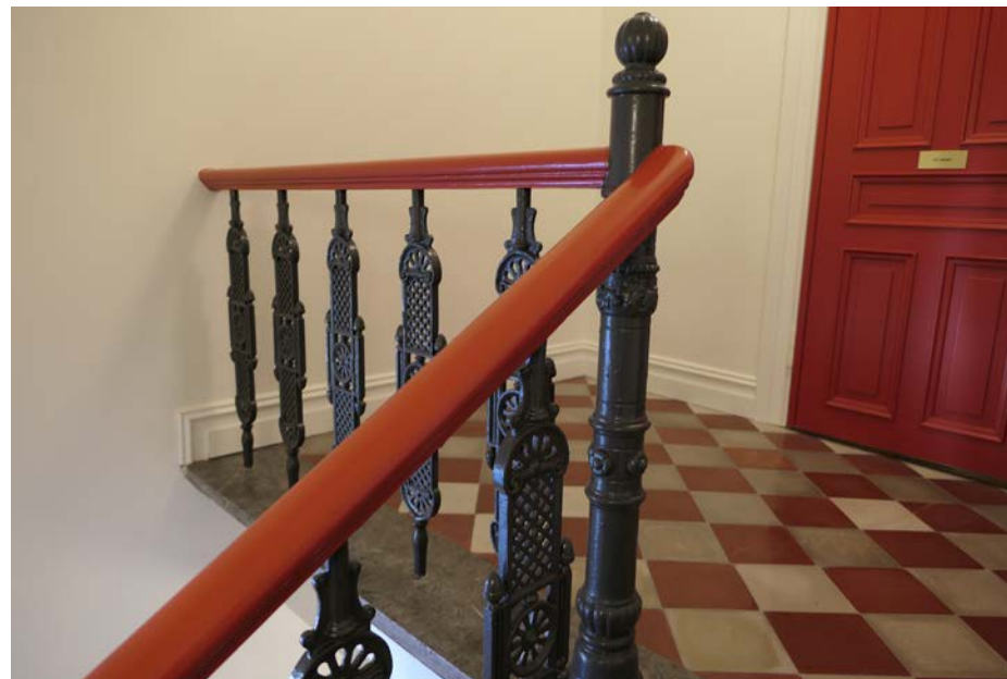
Detalj av ursprungligt gjutjärnsräcke i huvudtrapphuset Kastellgatan 12A. Golvet är belagt med ursprungligt cementklinker i schackrutsmönster.
