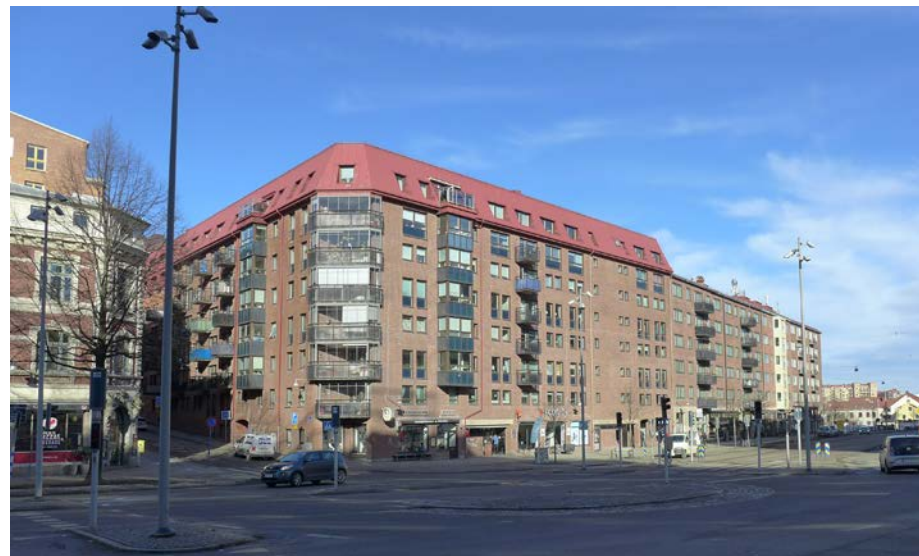
Kvarteret Batteriet från Brunnsgatan med 1980-talsbyggnaden i förgrunden.
