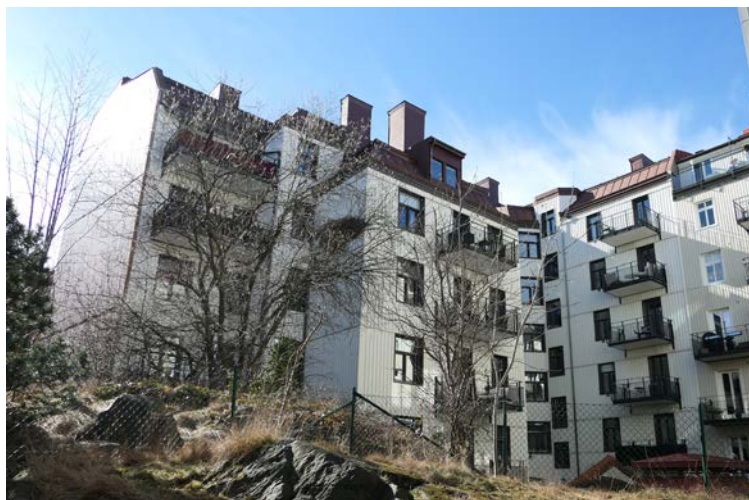
Gårdsfasad och gårdsbyggnad på Kastellgatan 8, uppförd 1903. Fasaderna är tilläggsisolerade och fönstren moderna. De ursprungliga takkuporna i gårdsbyggnaden är ombyggda under senare tid.
