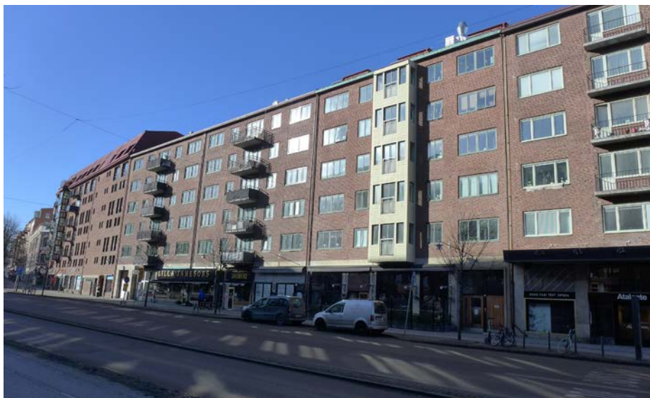
Övre Husargatan 3-11. Takfallen på 1930-talsbyggnaderna framträder inte i gatuperspektivet, däremot reser sig 1980-talsbyggnadens tak sig över funktisbyggnaderna.
