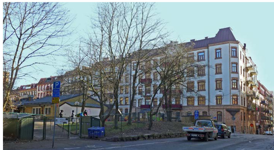
Vy mot kvarteret från Risåsgatan där taken har en hög exponeringsgrad. Taklandskapet har förändrats genom att ursprungliga takkupor tagits bort och att bl a tornet på hörnhuset förenklats kraftigt.
