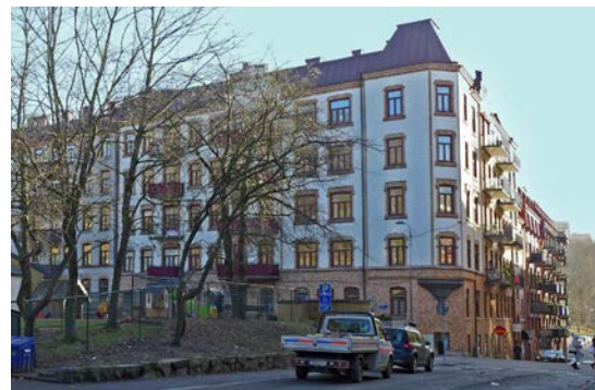
Fasad mot Kastellgatan. Tornöverbyggnaden togs bort 1954.
