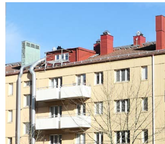
I takfall mot gården finns tvättstugans takkupa bevarad, dock försedd med nödbalkong.
