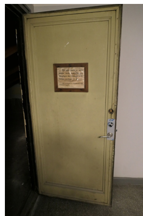
Ursprungligt spegeldörrblad mot fd piskplats.
