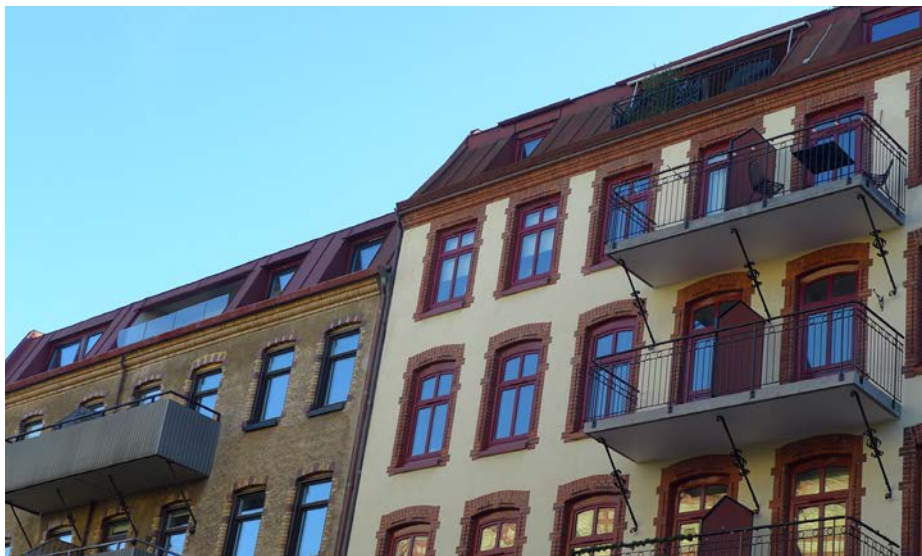
Takterrasser mot Kastellgatan som upptar en väsentlig del av det nedre takfallet och har inneburit en negativ påverkan på det ursprungliga arkitektoniska uttrycket.
