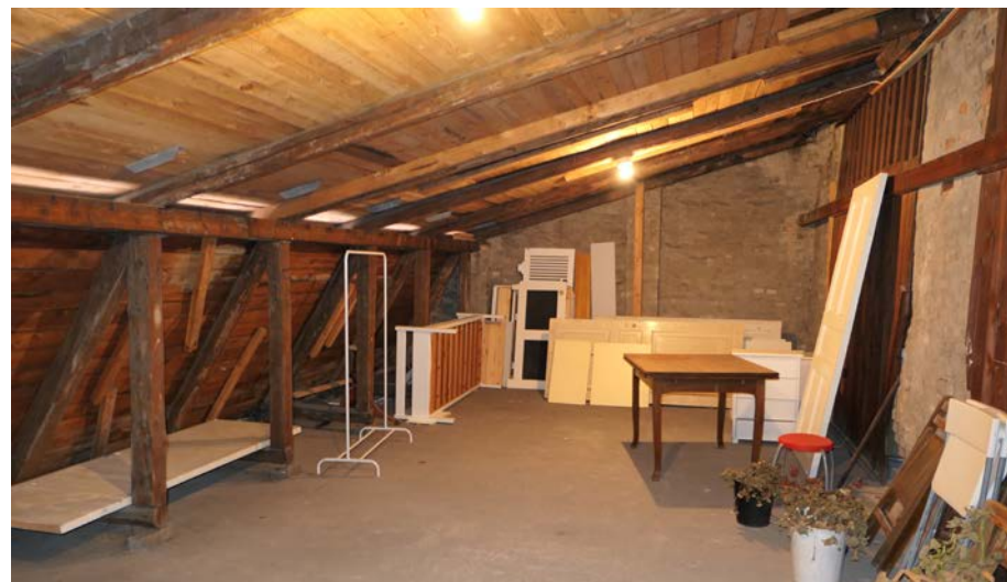
Kastellgatan 10, torkvind där takkupor mot gatan fanns förr.
