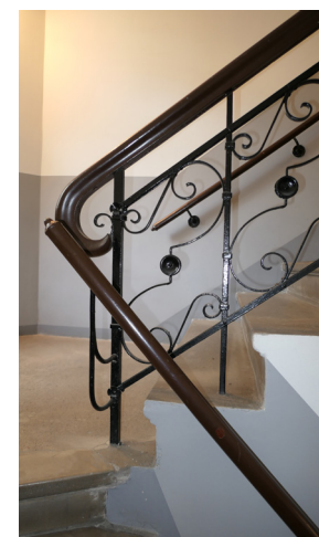
Huvudtrapphusen mot gatan är välbevarade med äldre cementplattor lagt i schackrutsmönster med fris, ursprungliga räcken av gjutjärn och stuckfriser på lägenhetsplan.
