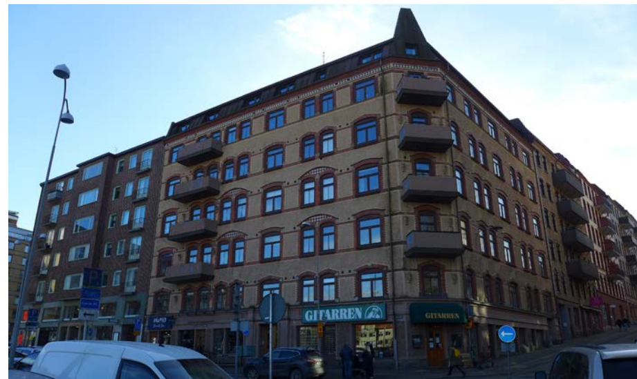
Gatufasad Skantorget 10, uppförd 1898. I takfallet har det tillkommit inverterade takkupor och tornet har förenklats. Balkongerna har försetts med moderna fronter av korrugerad plåt.
