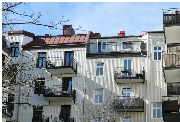
Gårdsfasad på Kastellgatan 6, uppförd 1903. Fasaderna är tilläggsisolerade och fönstren moderna. Mot gården har det tillkommit en takterrass.
